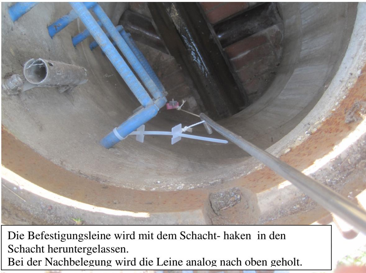
Die Befestigungsleine wird mit dem Schacht- haken in den Schacht heruntengelassen.
